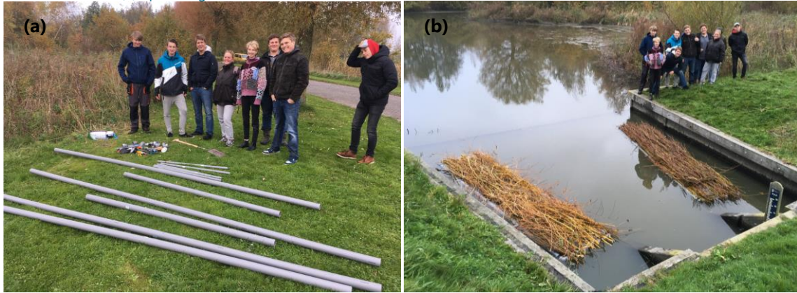
Afbeelding 3.36 Het resultaat van een middag werken met studenten van het Clusius college: . (a) het materiaal voor aanleg, en (b) oplevering van de constructies.
