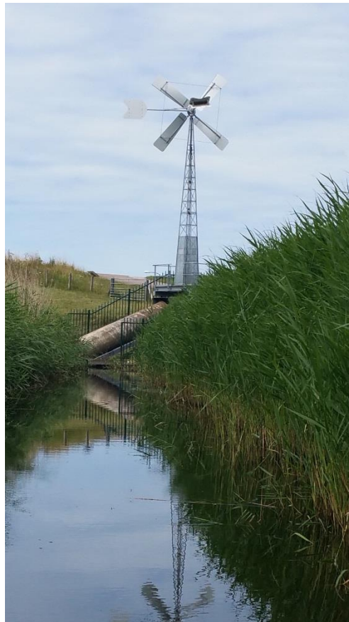
De buisvijzel en de windmolen in de Koopmanspolder.
