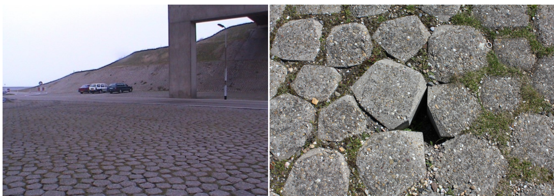
Afbeelding 3.6 Bekleding sluisplateau Roompotsluis
