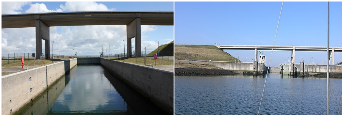
Afbeelding 3.6 Bekleding sluisplateau Roompotsluis
